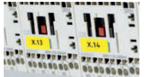
Kendinden yapışkanlı cihaz etiketi
