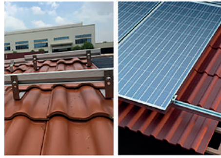
Kiremit Çatılar için Çatı Kancası Uygulamaları
